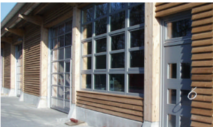
Ausschnitt der Nord-Westfassade
