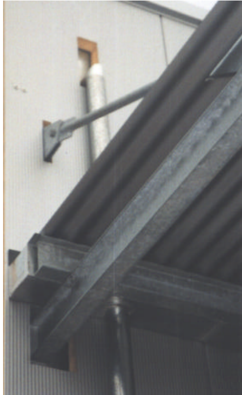
Gebüdeadanschluß: Wand-Vordach
