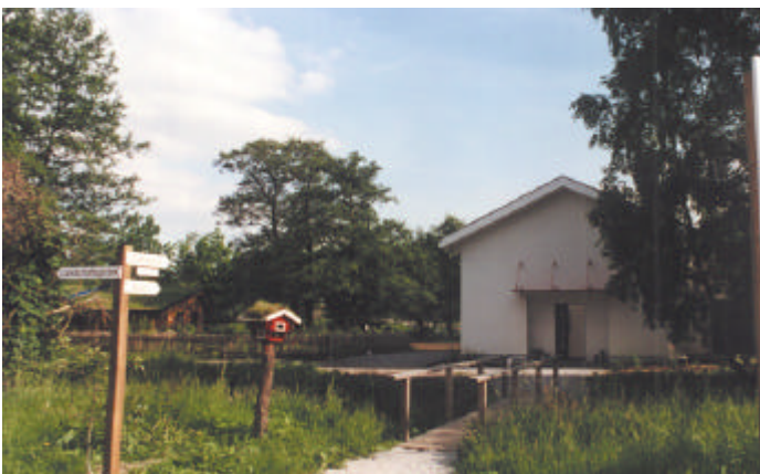
Blick auf die Nordseite des Bürogebäudes.
