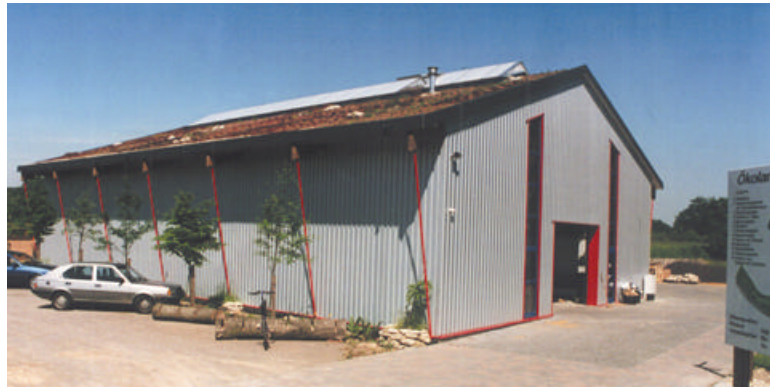
Produktions- und Lagergebäude mit Sozialtrakt
