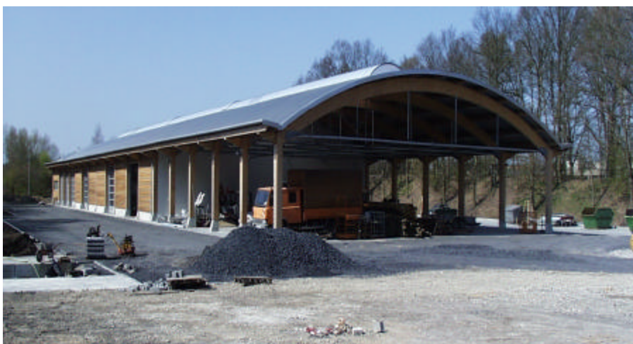
Süd-Ostseite, mit dem offenen Hallenbereich im Vordergrund
